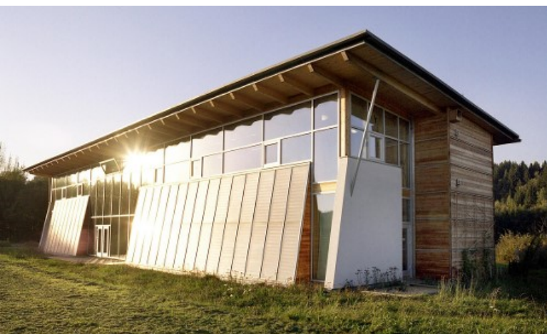
Das Sonnenhaus in Zwiesel (Foto: Naturpark)
